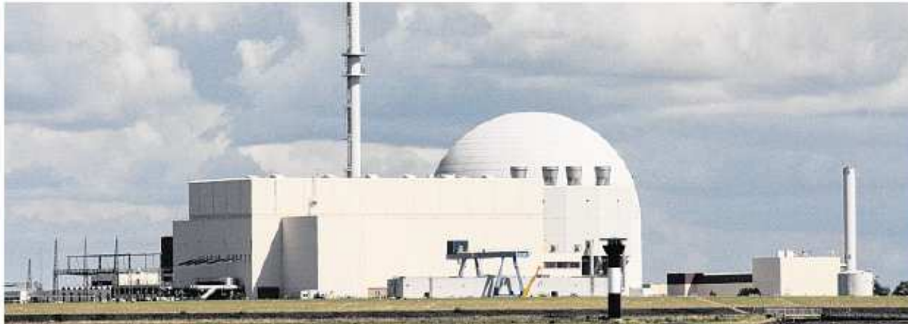
Statt wie sonst üblich im Frühsommer geht das Kernkraftwerk Brokdorf jetzt schon am kommenden Wochenende vom Netz. Die letzte Revision liegt erst sieben Monate zurück. Diesmal werden auch Brennelemente gewechselt. KOLZ
